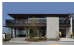
7 積水ハウス シャーウッド【木質系】
